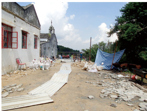
為破爛的恩光堂 進行復修工程。
